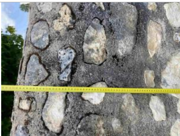
Photographie du mur (CIVA15)
