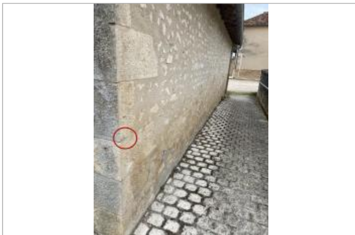
Mur de la grange (restaurant la Bisquine)
