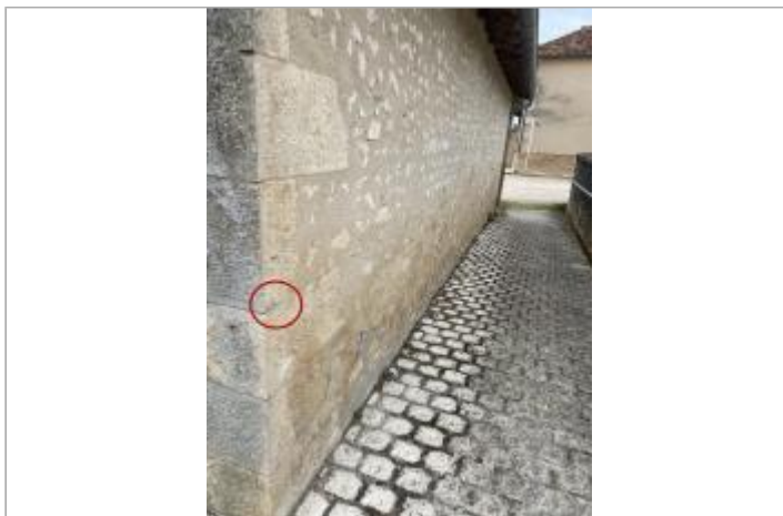
Mur de la grange (restaurant la Bisquine)
