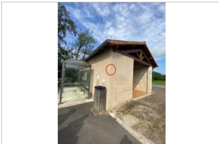
WC public (côté parking)
