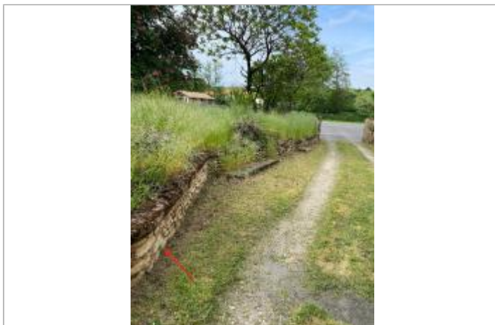
Muret au 4 route du fond d'Orveau
