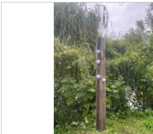
Vue du totem installé et de ses 4 repères de crue
