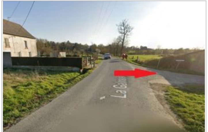
chaussée de la RD 286 au lieu-dit La Galnais coté route de la Belle Epine
