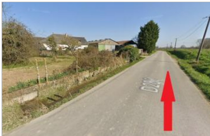
Chaussée de la RD 286 au lieu-dit Rollard
