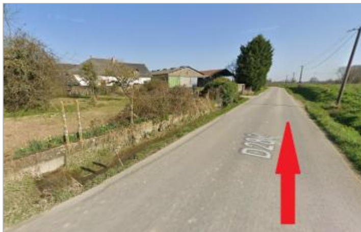
Chaussée de la RD 286 au lieu-dit Rollard
