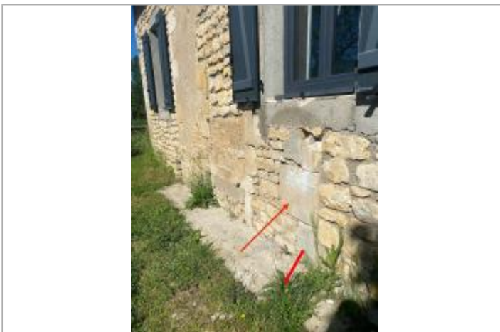
Site - façade du 4 Route du fond d'Orveau
