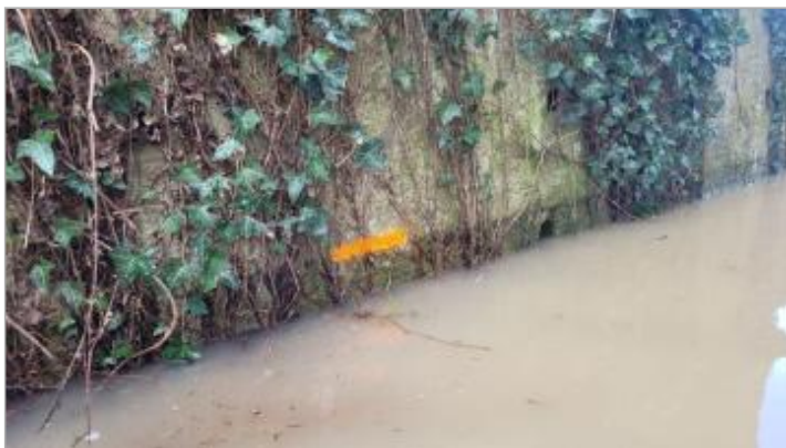
marque à la peinture du niveau maximum de l'inondation
