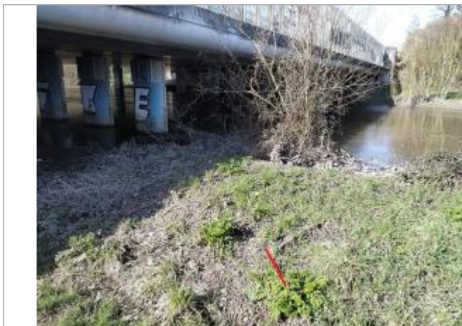
En amont du pont de la rocade Est, rive gauche
