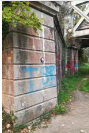
Pile de l'ancien pont SNCF
