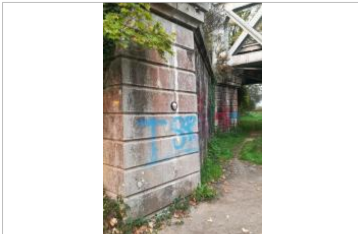
Pile de l'ancien pont SNCF
