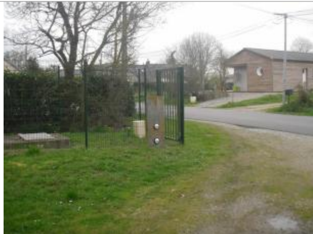
Poteau près de la station de relèvement à Augrain
