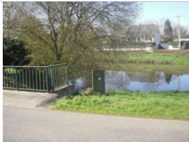
poteau sur le coté du pont de la RD39
