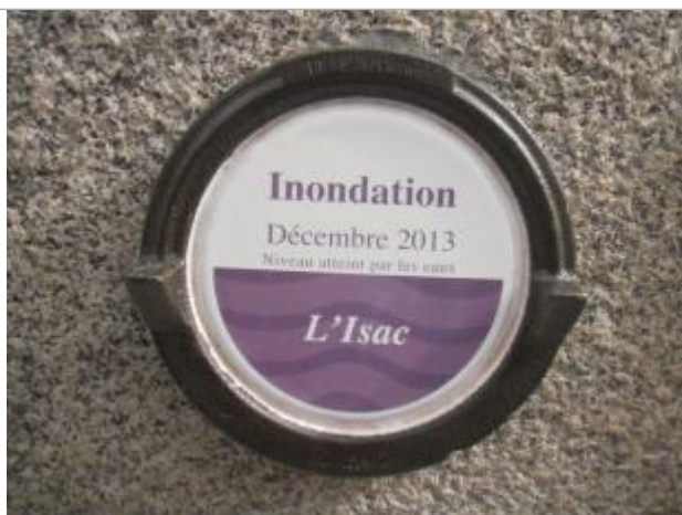
Repère normalisé près de la porte d'entrée
