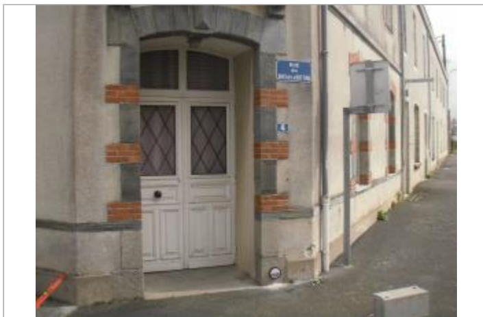
Porte d'entrée du 4 rue du bois de la Bottine à Saffré
