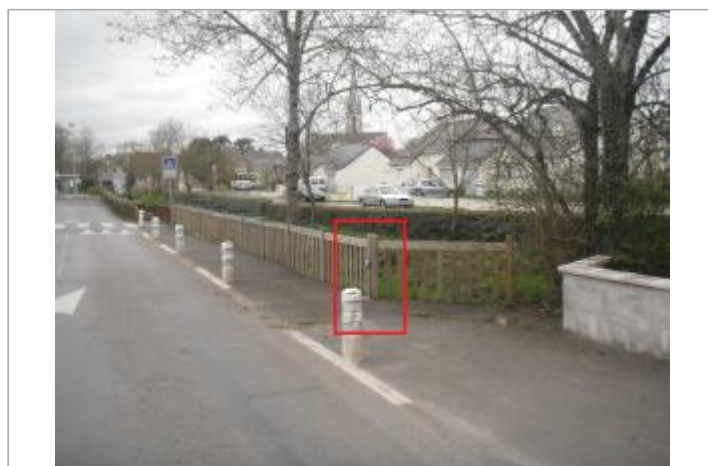
Poteau rive gauche rue de l'Isac à Saffré
