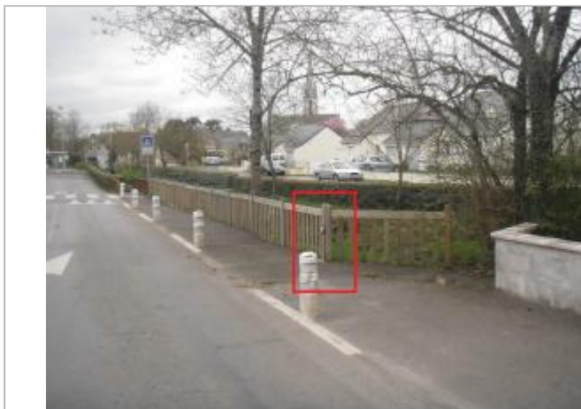
Poteau rive gauche rue de l'Isac à Saffré
