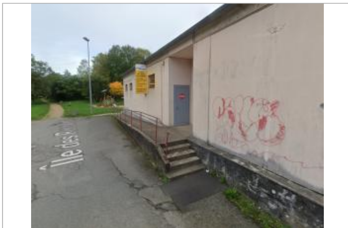
Entrée du bâtiment
