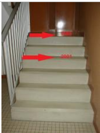
marche à l'intérieur du bâtiment (2001)
