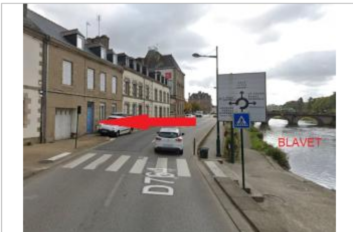
Garage au n°13 quai Niemen
