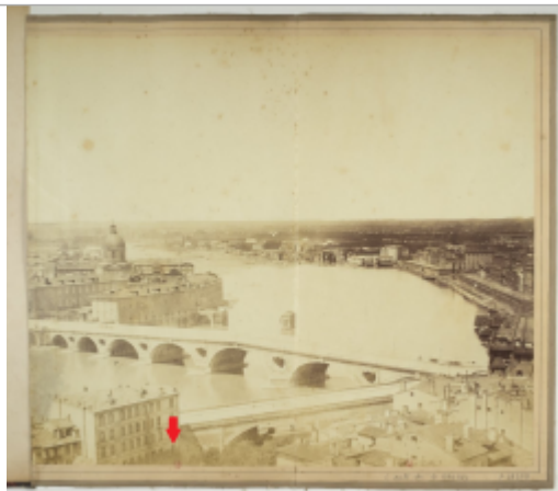
Photo d'époque à partir de laquelle la levée de la laisse de crue de 1875 a été réalisée
