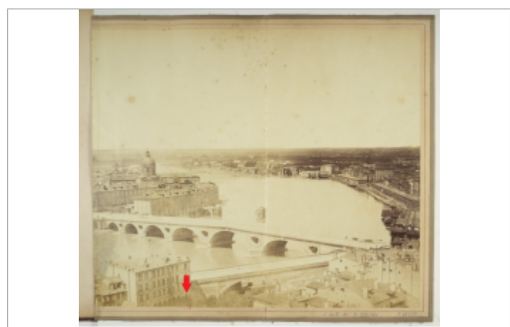
Photo d'époque à partir de laquelle la levée de la laisse de crue de 1875 a été réalisée
