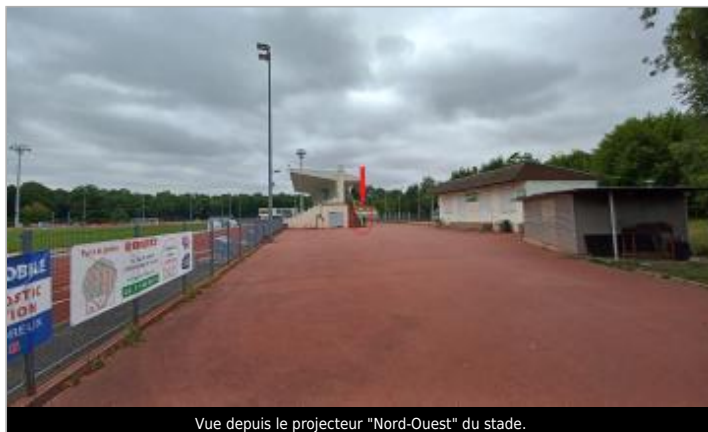
Vue depuis le projecteur "Nord-Ouest" du stade.
