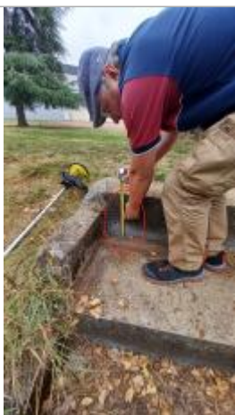
Laisse de crue à 14 cm/sol.
