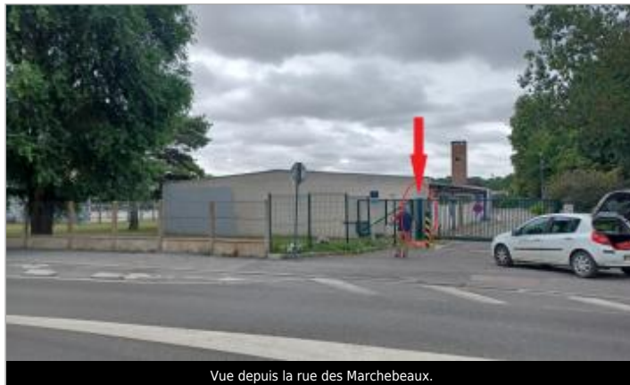
Vue depuis la rue des Marchebeaux.
