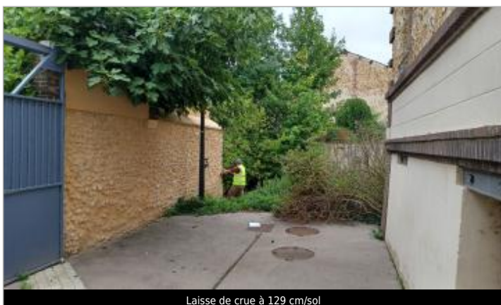
Laisse de crue à 129 cm/sol
