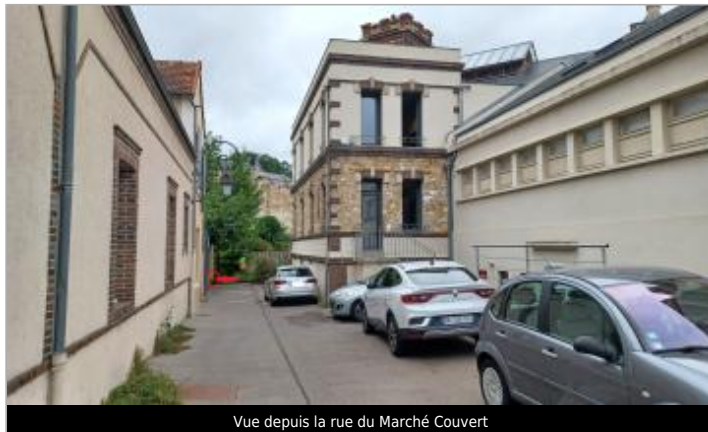
Vue depuis la rue du Marché Couvert
