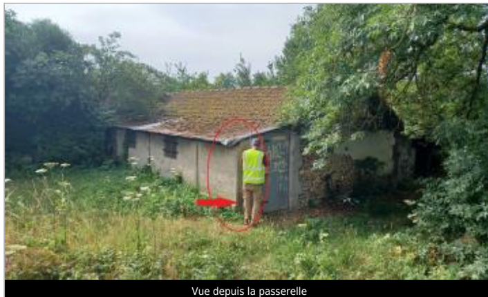
Vue depuis la passerelle
