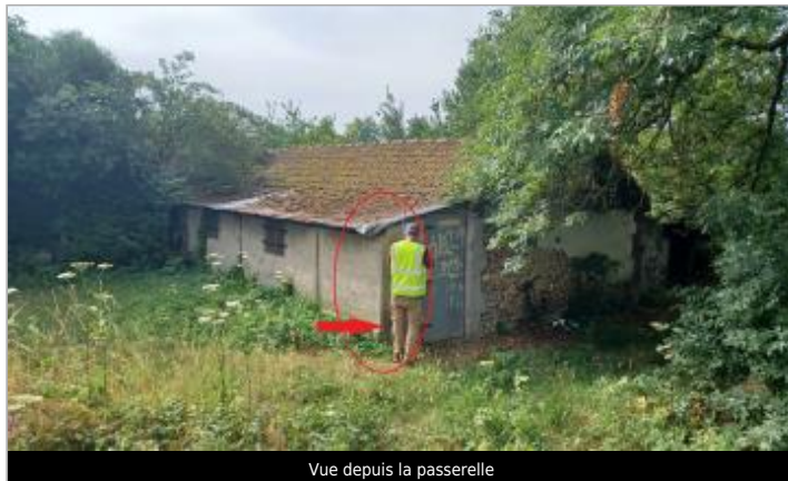
Vue depuis la passerelle
