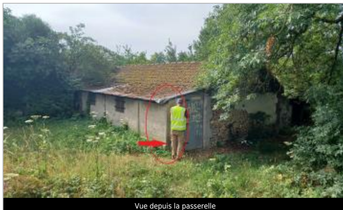
Vue depuis la passerelle
