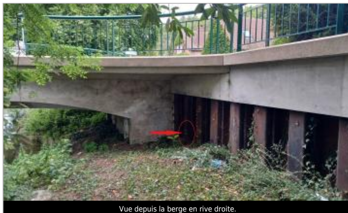
Vue depuis la berge en rive droite.
