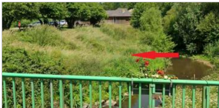
rampe d'accès à la rivière en amont du pont de la RD25
