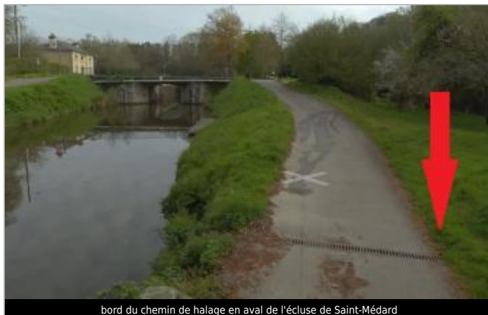
bord du chemin de halage en aval de l'écluse de Saint-Médard
