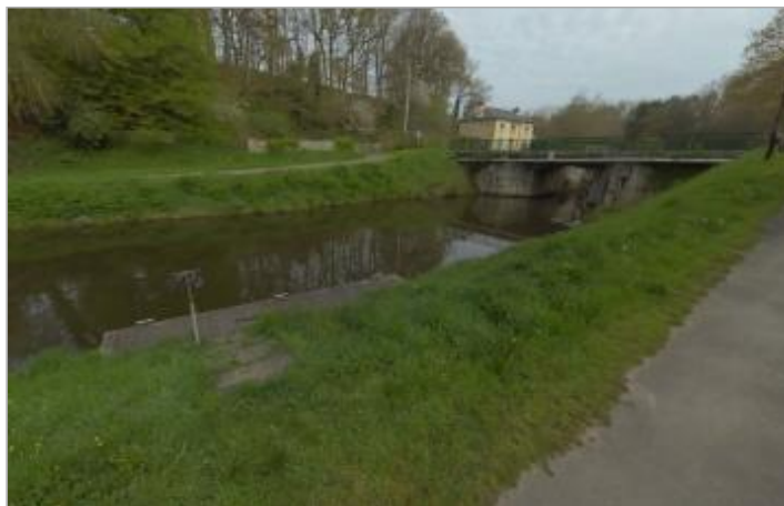
quai d'appontage en aval de l'écluse de Saint-Médard
