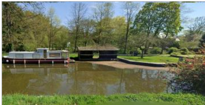
quai d'appontage en amont de l'écluse de Saint-Médard
