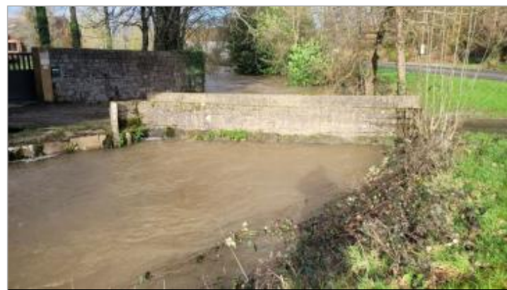
pont d'accès au moulin, rive gauche en aval du pont
