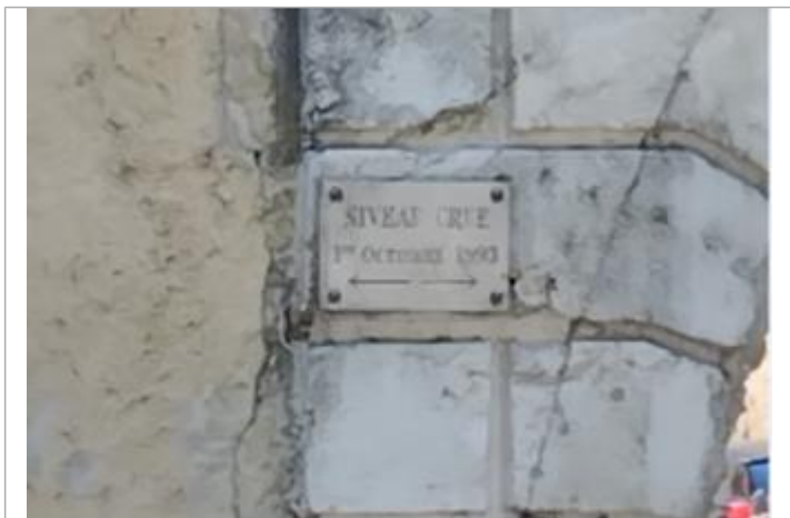
repère porte nord
