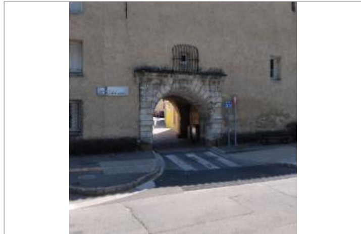
Ancienne porte Nord - cours de la république
