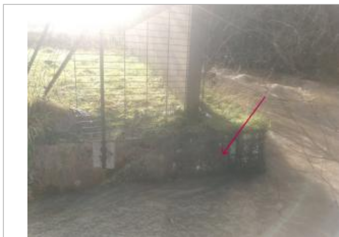
Muret de droite_ouvrage de la Roquette_Tourville (SMBVR)
