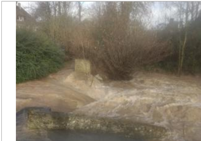
Ouvrage_de la Roquette (SMBVR)
