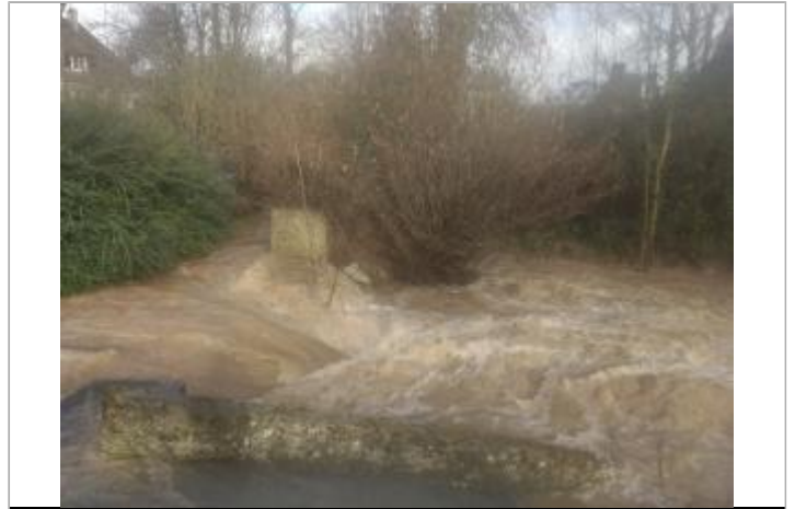
Ouvrage_de la Roquette (SMBVR)
