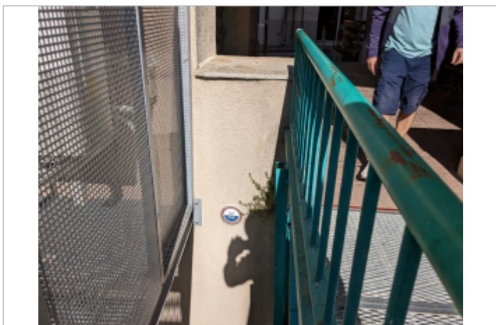
reper passerelle piétonne
