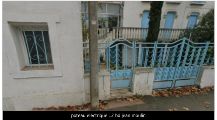
poteau électrique 12 bd jean moulin
