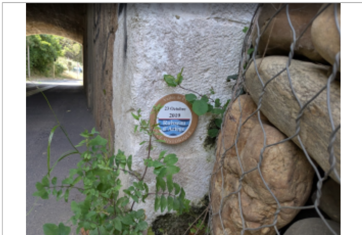
pont sncf avenue romarin
