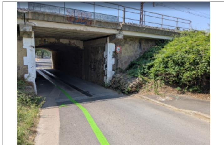
pont sncf route romarin
