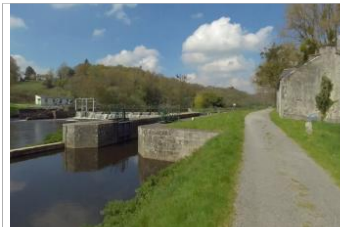
Ecluse de Moulin Neuf aval à Pluméliau-Bieuzy
