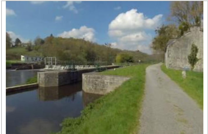
Ecluse de Moulin Neuf aval à Pluméliau-Bieuzy
