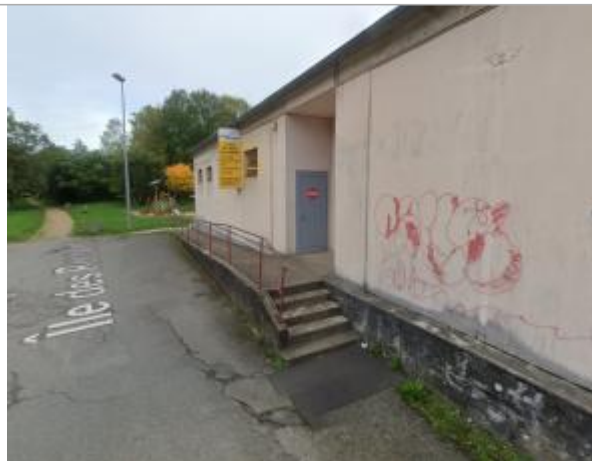
Entrée du bâtiment
