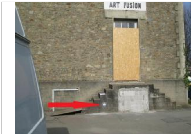
escalier entrée du bâtiment
