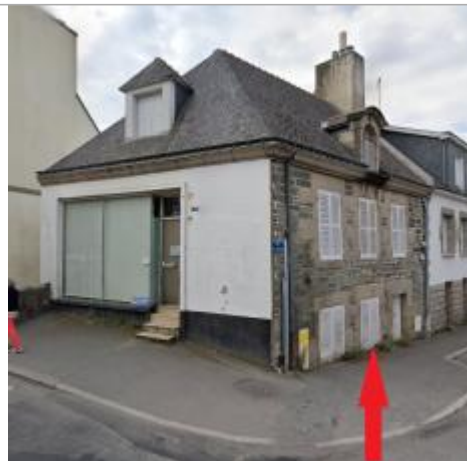
Maison au 9 rue du Général Quinivet
