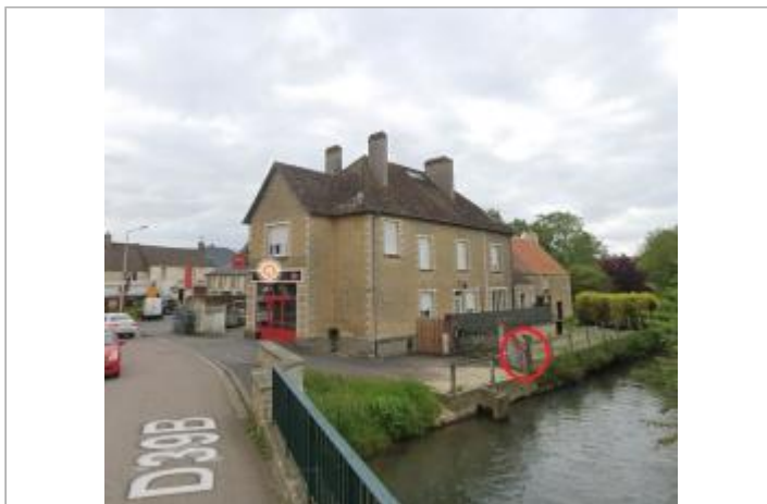
Vue depuis le pont
