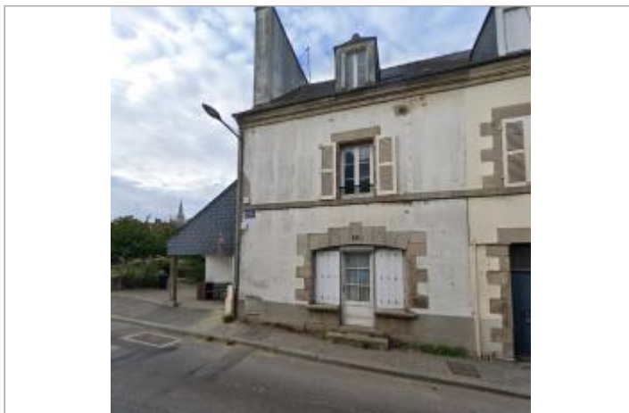
Maison au 5 rue du Général Quinivet
