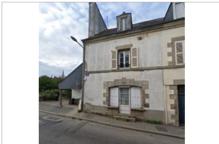
Maison au 5 rue du Général Quinivet
