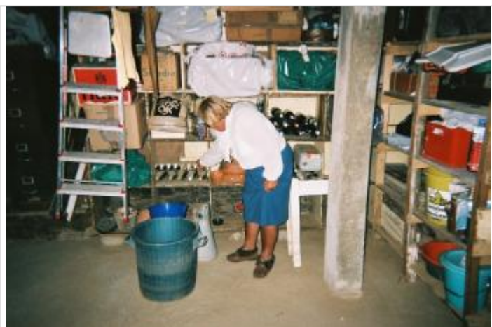
Laisse de l'inondation dans le sous-sol de la maison
