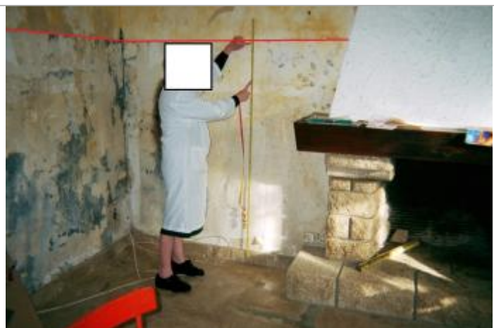
Laisse de l'inondation de janvier 2001 sur le mur intérieur de la pharmacie
