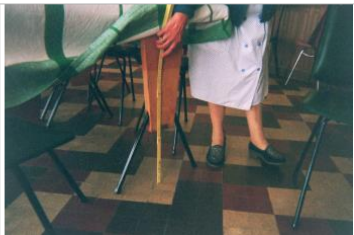
trace de l'inondation de janvier 2001 dans l'habitation
